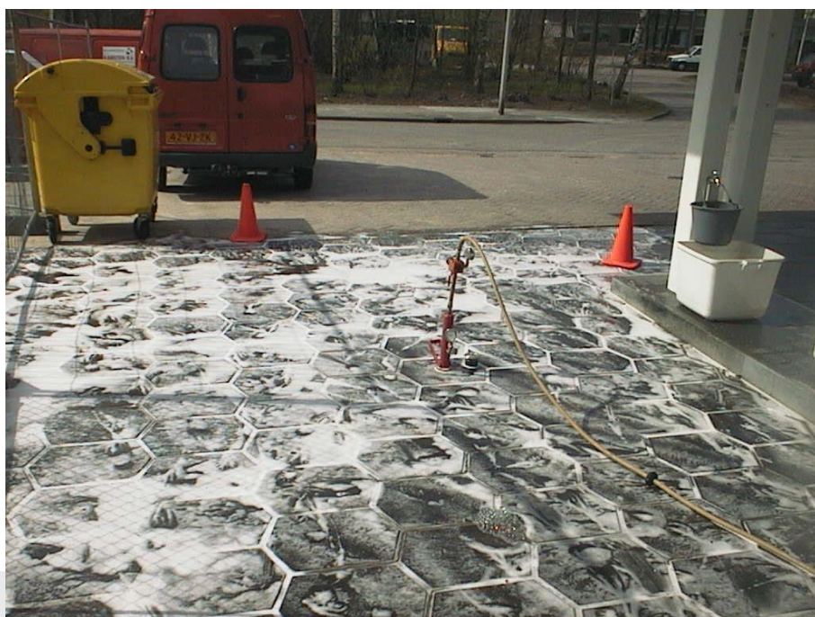
Foto: Inspectie uitgevoerd overeenkomstig protocol 6704.
