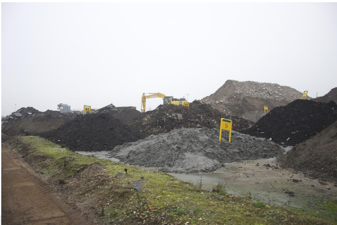
Foto: Mogelijke inspectielocatie voor geo-elektrische meting.
