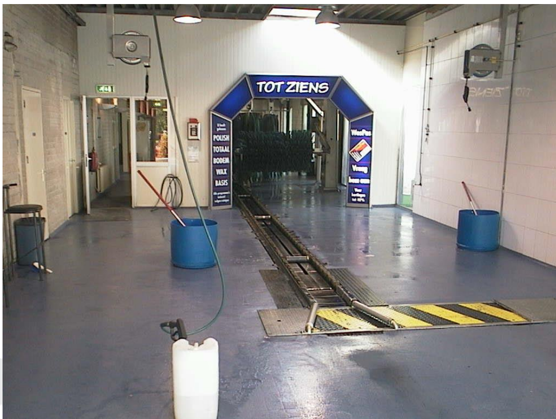
Foto: Voorbeeld te inspecteren vloeistofdichte voorziening.
